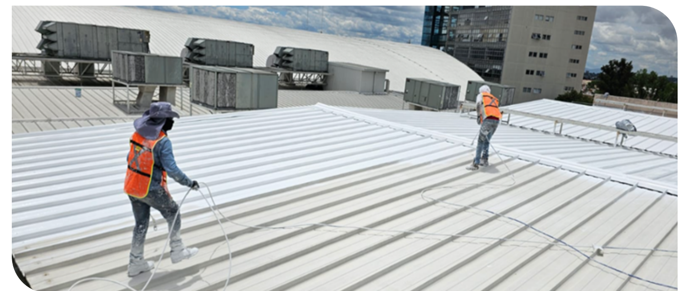
Impermeabilización del 60% del edificio.
