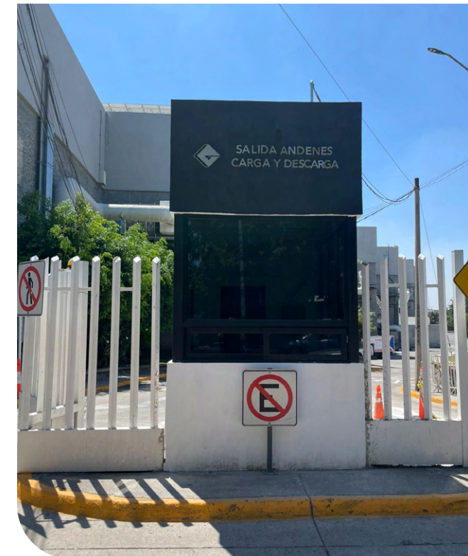
Remodelación de caseta, acceso M. Otero.
